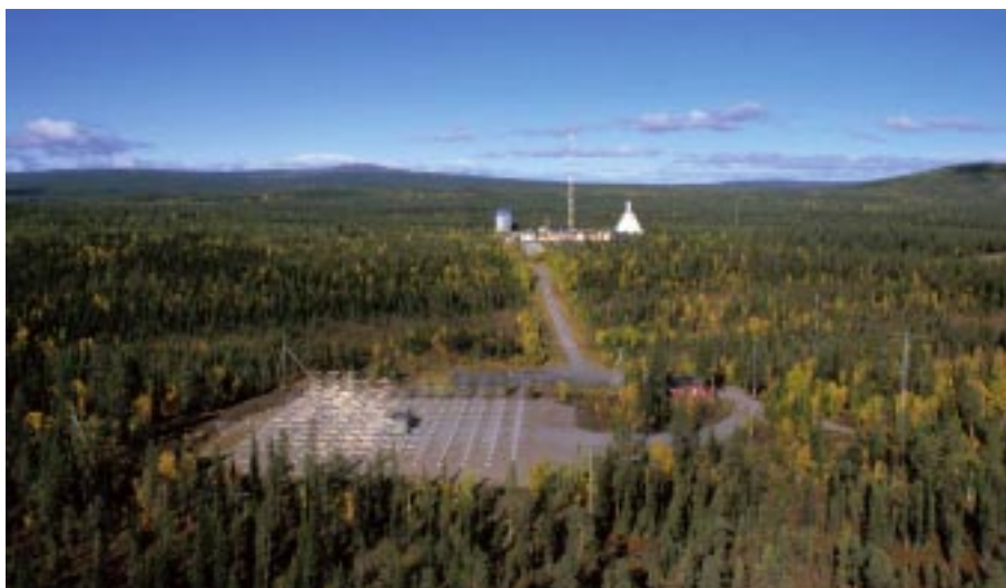
Fig. 3.2.3 ESRAD MST-radarn används för studier av mesosfären, stratosfären och troposfären (Bild: SSC Esrange)
