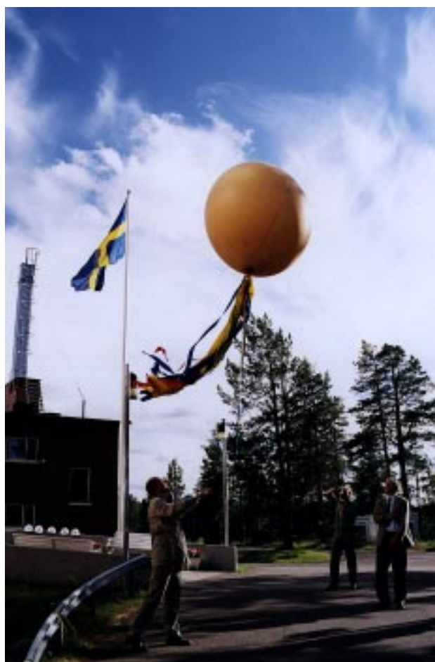
Fig. 2.3 Utbildningsministern Thomas Östros var närvarande vid "första spadtaget" för tillbyggnaderna av Kiruna rymdcampus vid IRF (Bild: Joakim Gimholt)
